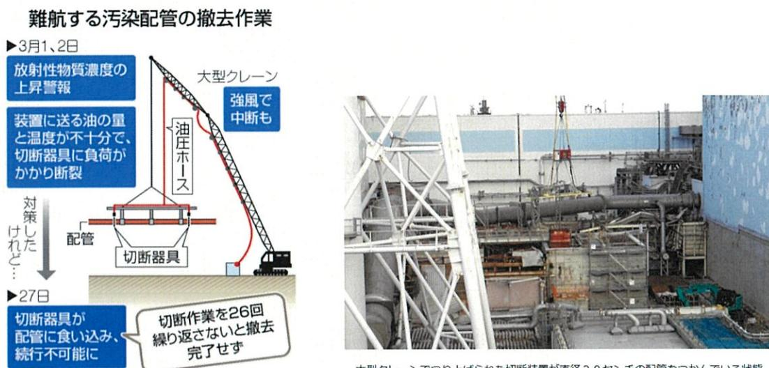
図-2 撤去作業の中止の状況
