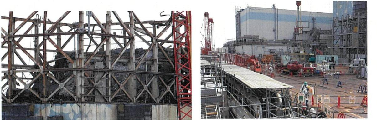
① 水素爆発で上部が吹き飛んだ 1 号機原子炉建
