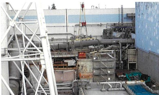
⑤ 高濃度汚染したベント配管撤去のため、クレー
