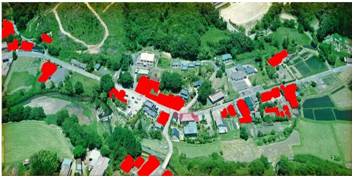
拠点区域内の津島地区中心街 2024.10.18 進行協議時、赤塗り潰しの家屋は既に解体撤去済み ○は、その後現在までに解体撤去された家屋のこと
