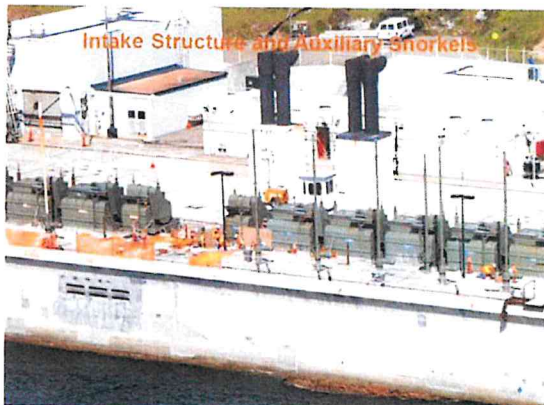
ディアブロ・キャニオン原子力発電所の取水口に設置された海水冷却水ポンプのシュノーケル
