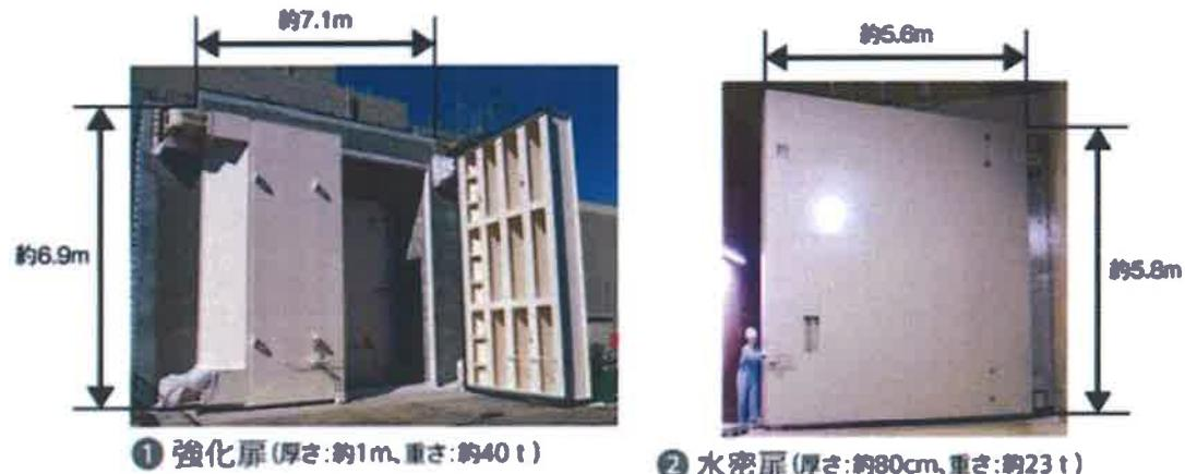
大物搬入口などの建屋の開口部の水密化とともに、建屋内部への浸水を完全に防ぐことに失敗した場合に備えて、配電盤等が設置されている部屋等について、水密扉の設置等によって、重ねて水密化による防護措置を講じておく必要がある。建屋内部の水密扉の実例は、次のとおりである。
