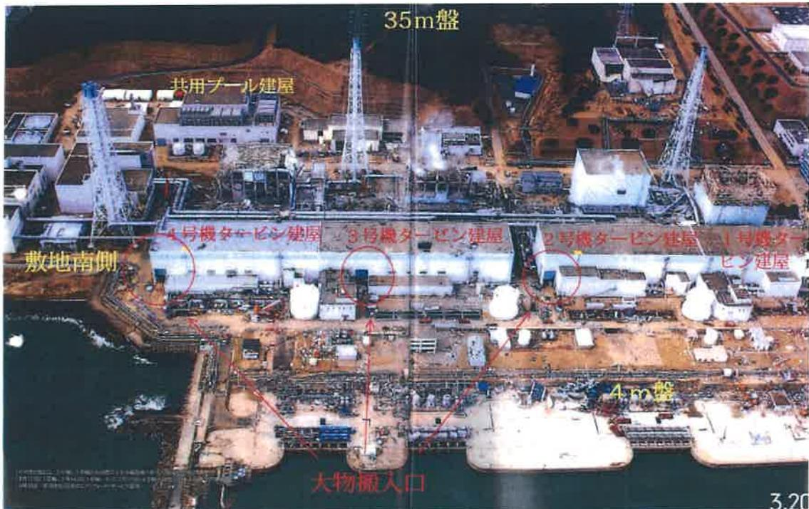
これは本件事故直後の3月20日に、福島第一原癁を東側の海の上から見下ろした写真である<sup>11</sup>。タービン建屋が右側から1, 2, 3, 4号機の順で並んでいるが、1号機と2号機、3号機と4号機のタービン建屋は合体しており、合体した号機間では電源の融通が可能となっていた。タービン建屋の手前東側が、海水ポンプなどが設置されていたO.P.+4m盤である。タービン建屋の奥の西側に各号機の原子炉建屋があり、1, 3, 4号機の原子炉建屋は水素爆発で大破している。
