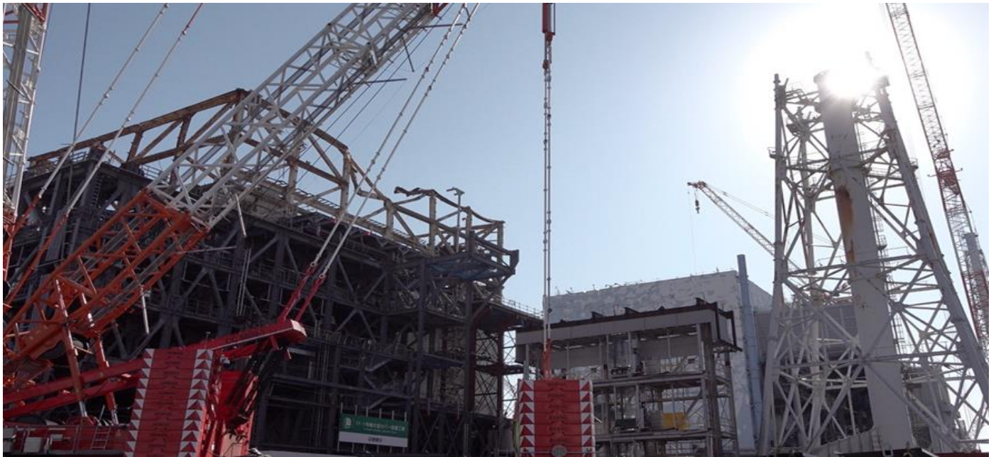
写真：使用済み核燃料の取り出し準備が進む1、2号機（筆者撮影）
